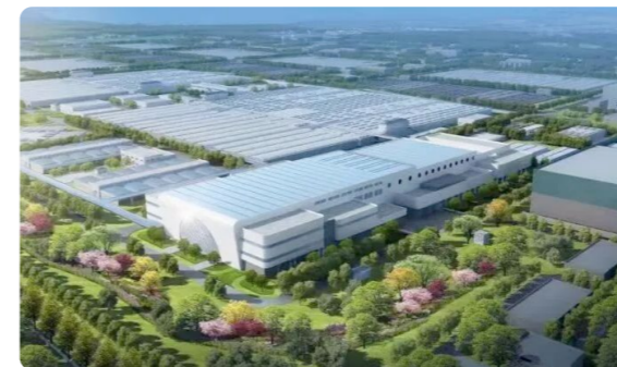
上海白龙港污水厂三期扩建工程
