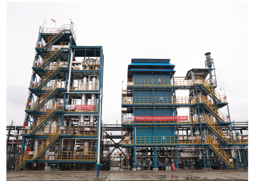
2026年1月，千吨级沼气全碳定向转化制绿色甲醇中试装置投运
